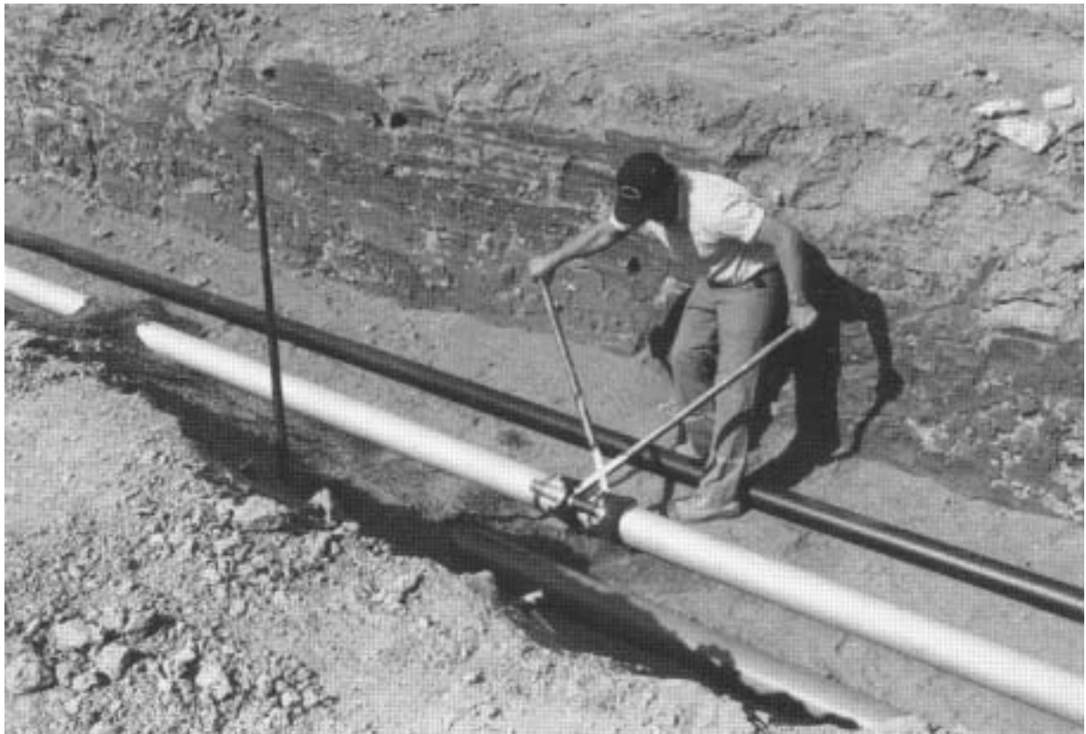
Läggning och hopfogning av vattenledningsrör av rostfritt stål från Rostfria VA-system i Storfors AB.
